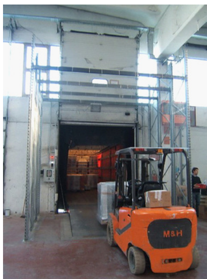
Fig. 6.4. Arqueta instal·lada a l'entrada de descàrrega.
