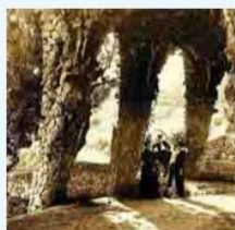
Viaducte del museu (1904)
