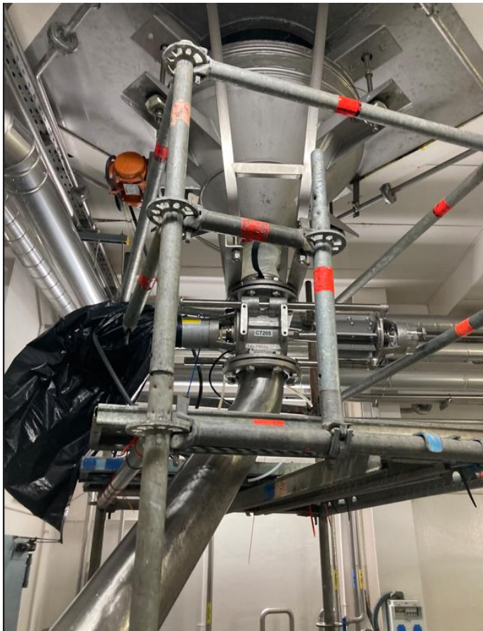
Figura 8-14. Bastida muntatge instal·lació
