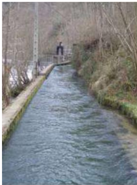
Fig. 4.4 Canal de derivació [2]
