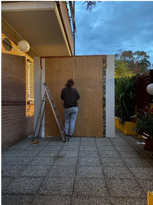
Fig. 10.36. Muntatge set. Autor: Elaboració pròpia.
