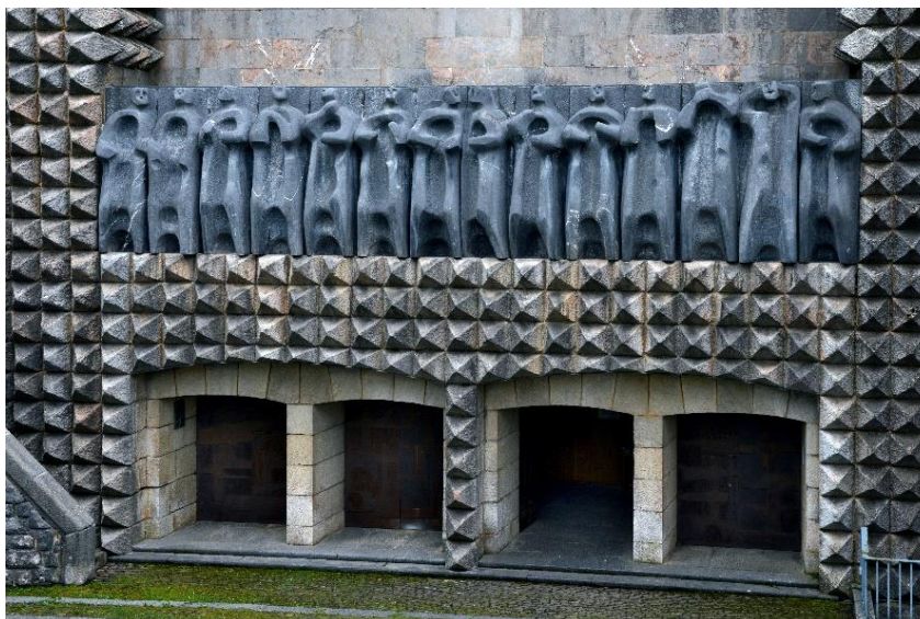
Figura 49. Jorge Oteiza. Entrada de la Basílica d'Arantzazu. Estatuària. Font: (Oteiza, Façana Basílica d'Arantzazu [Estatuària], 1968)
