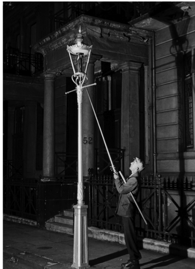
Fig 2.4 Alumbrado de gas manual en la vía pública
