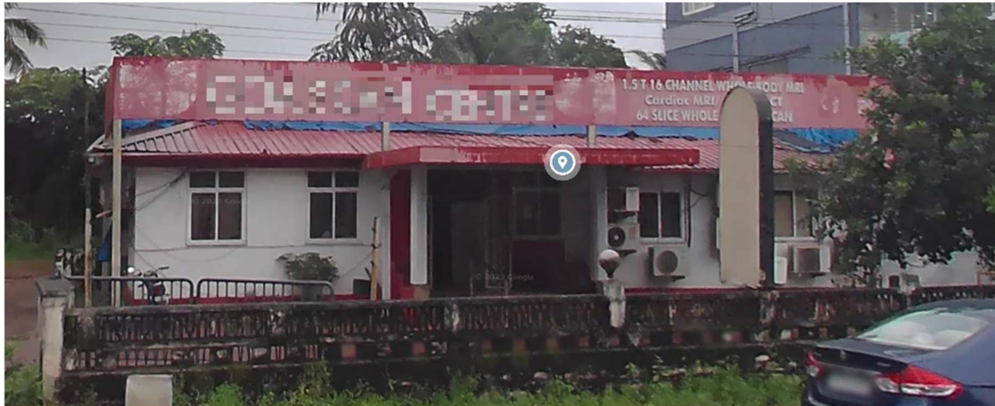
Fig. 3.2.1.3.4. Centre mèdic del servidor. Font: Elaboració pròpia.
