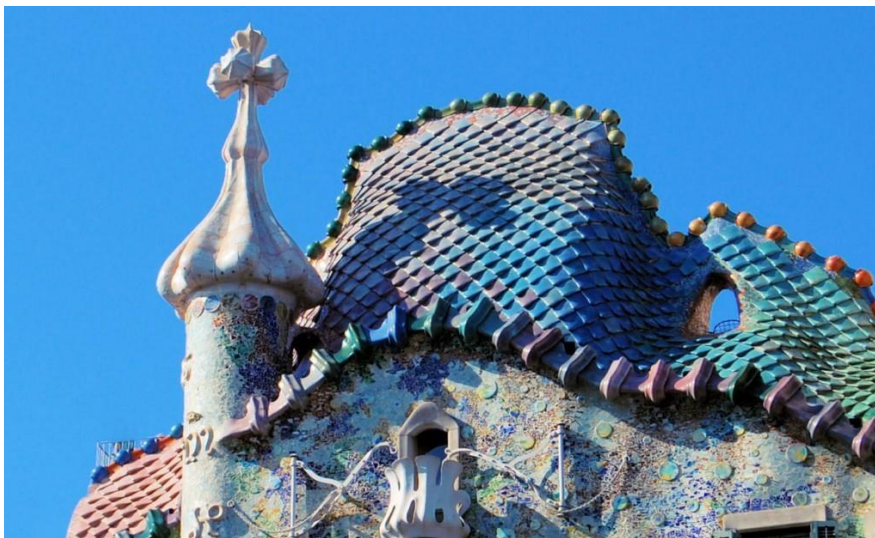
Figura 10: Tejado de la Casa Batlló.
