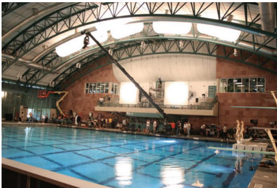
Fig. 4.4.24.: Globos de iluminación hechos por Airstar utilizados como luz ambiental en una piscina. Fuente: Brown, 2008.
