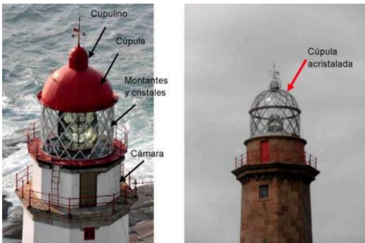
Figura 10. Parts de la llanterna d'un far (dreta) i cúpula d'un aerofar (esquerra)
