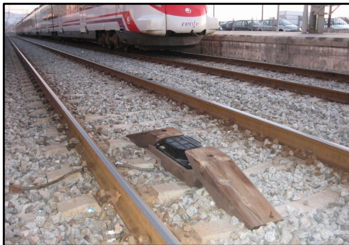
Figura 2.2.2.1 - Balisa ASFA a la línia de Rodalies Barcelona - Mataró
