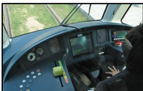
Figura 3.2.4.5 - Taulell de control cabina ATP (Font: www.tramvia.org )
