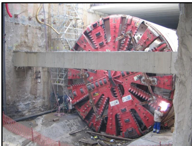
Figura 2.2.10.2 - Obres de construcció de la futura L9 del Metro de Barcelona (Font: Agrupament Ferroviari de Barcelona - www.agrupament.net )
