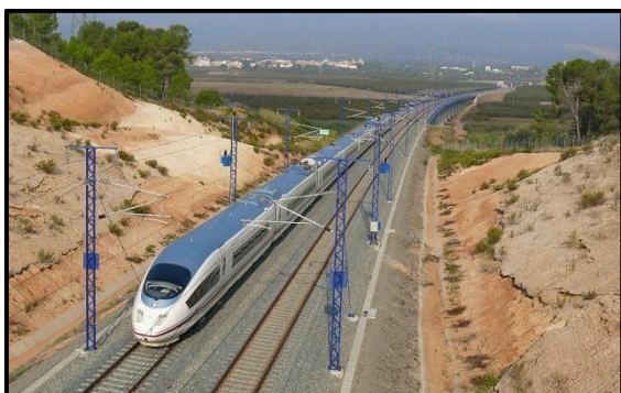
Figura 5.1.8 - Tren AVE en circulació (Font: Bernat Borràs - www.trenscat.cat)
