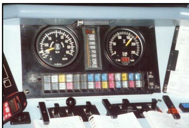
Figura 2.2.5.2 - Panell de control de cabina LZB (Font: Ferropedia - Article "Linien Zug Beeinflussung")
