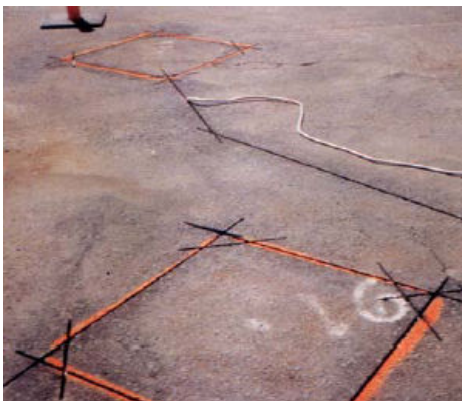
Figura 5. Llaç inductiu en construcció
