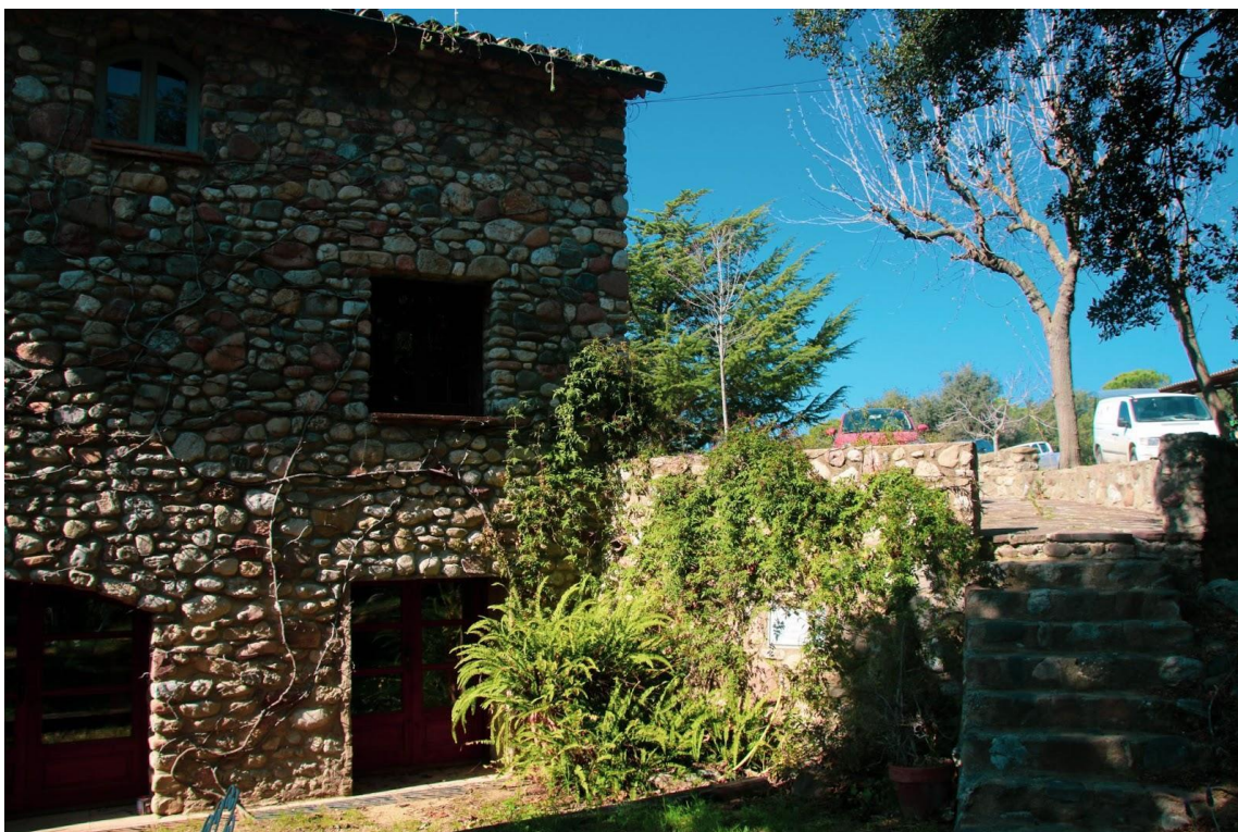
Figura 10.3.9. Part posterior de la casa, paret de pedres. (Elaboració pròpia, 2021)
