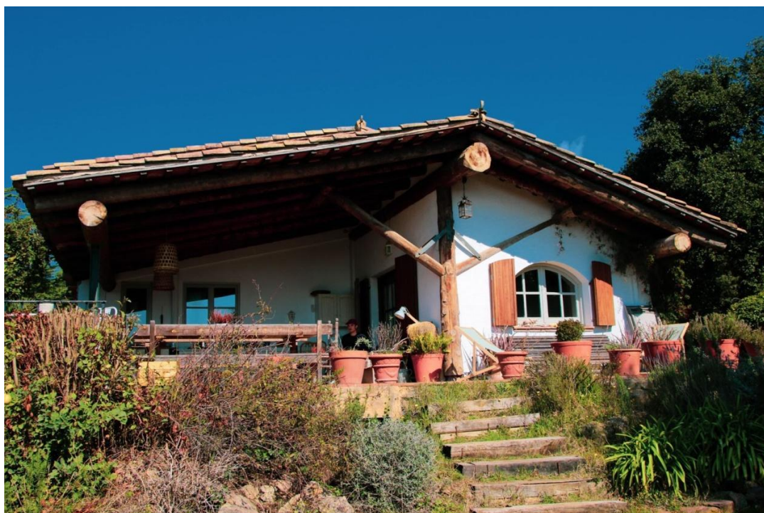
Figura 10.3.2. Part posterior de la casa. (Elaboració pròpia, 2021)
