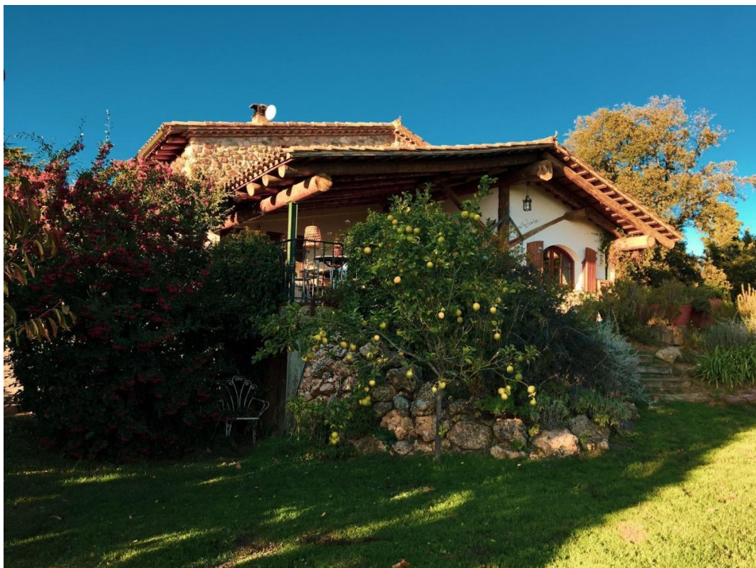
Figura 10.3.1. Part posterior de la casa. (Elaboració pròpia, 2021)
