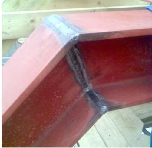
Il·lustració 13: Unió amb soldadura.
