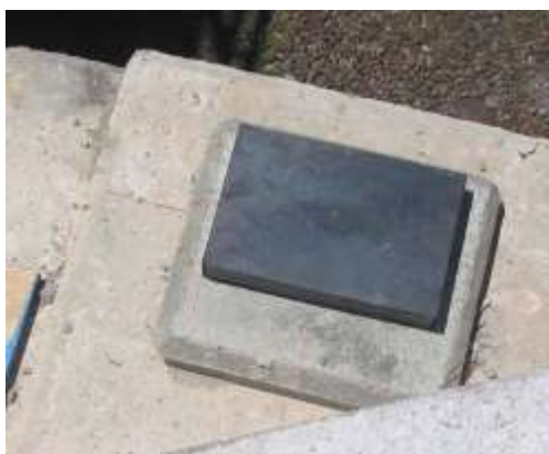
Il·lustració 107: Junta elastomèrica de neoprè.
