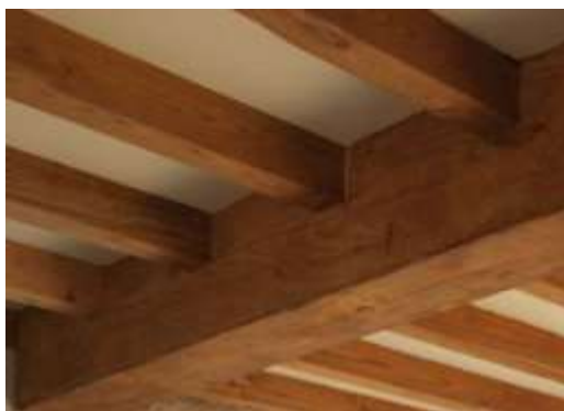
Il·lustració 100: Unió quartó longitudinal - quartó transversal.
