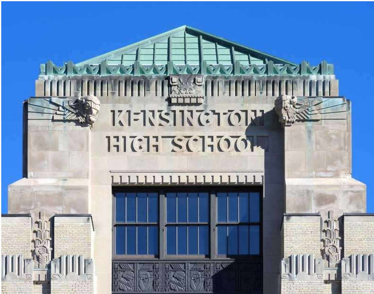
Figura 4.19. Fachada de hormigón de la Kensington High School en Nueva York, por Chuck LaChiusa
