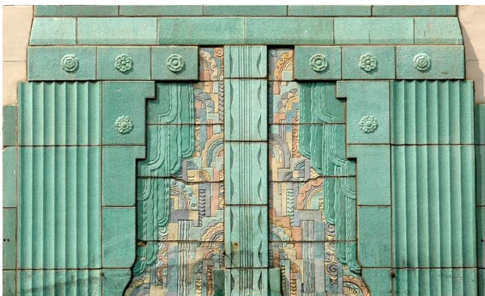
Figura 4.20. Detalles en color de una fachada en terracota, por Terence Faircloth
