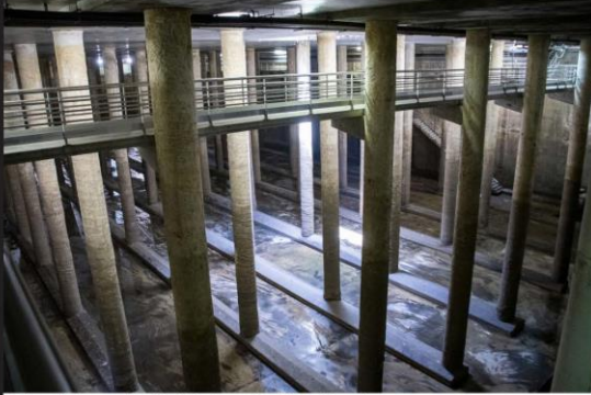
Diposit de regulació d'aigües pluvials - Barcelona
