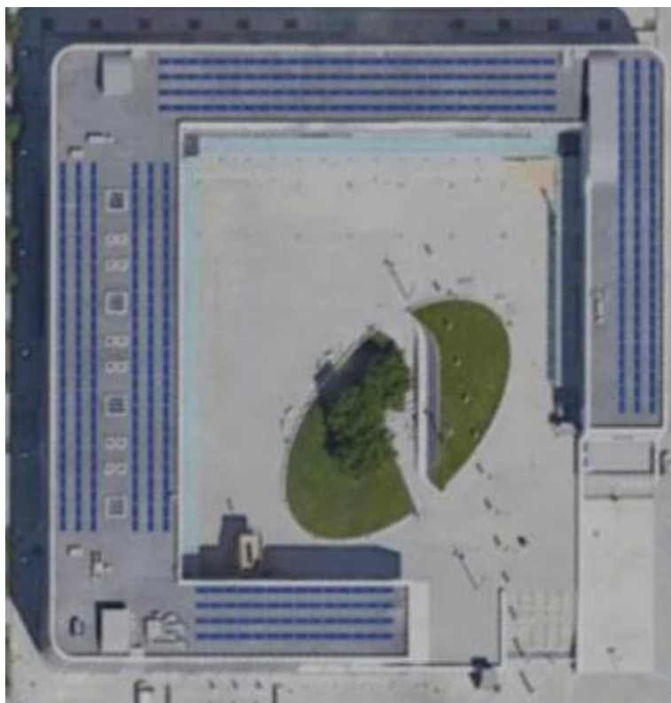
Figura 9.1 Distribució fotovoltaica en coberta de l'edifici TCM1.
