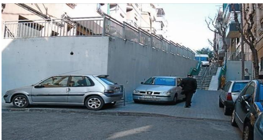
Fig. 5.9.4 Calles de Hospitalet de Llobregat
