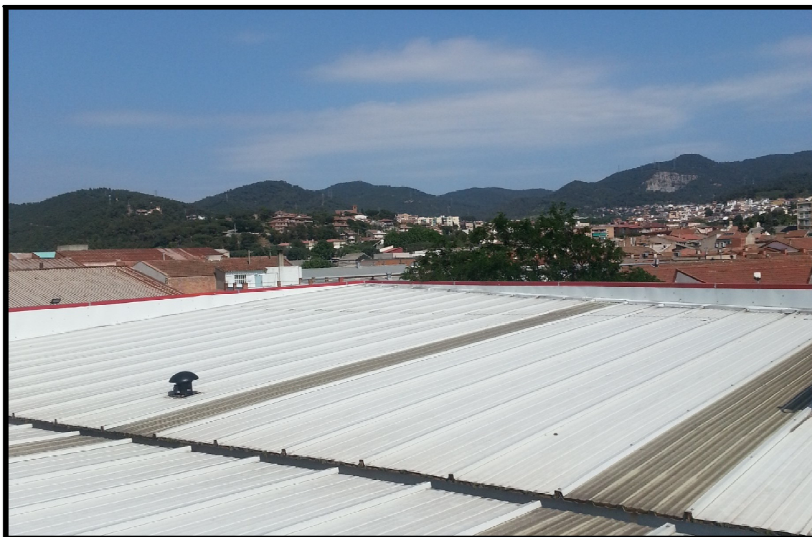
Fig. 4.7 Foto de la coberta on aniran les plaques solars fotovoltaiques
