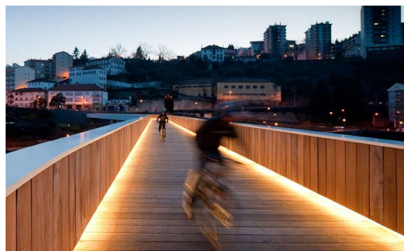
Figura 3.24: Enllumenat col·locat en la base de l'estructura.
