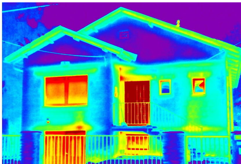
Fig. 2.9 Termografia a façana d'edifici (Font: Testo AG)
