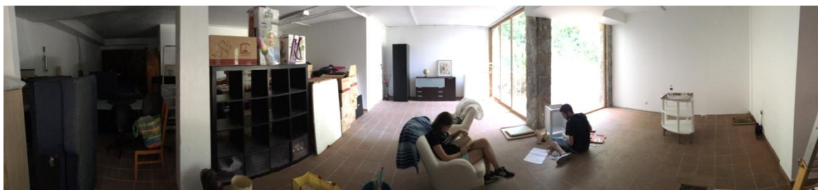
Fig. 5.1.7.1.1. Panoràmica habitació de Joanna en construcció. Font: Noe Sánchez.
