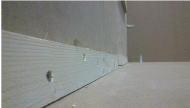
Fig. 3.14. Reforços amb llistons de fusta.
