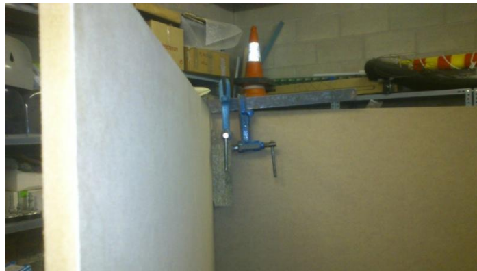
Fig. 3.13. Construcció dels dos tablonos amb un angle de 45°.
